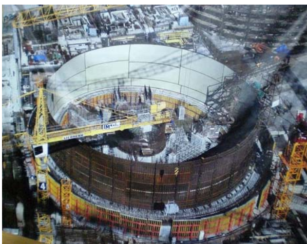
2.4.4.2-1. ábra: Az épülő erőművi blokk Szosznovij Borban
