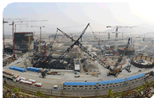
2.4.4.4-2. ábra: Taishan 1–2. építési munkái
