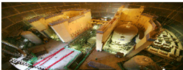
2.4.4.5-1. ábra: Munka a konténment épületben a Shin-Kori 3. blokkon
