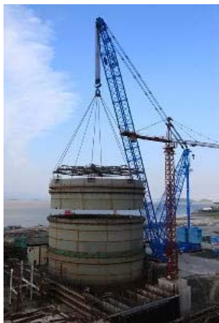
2.4.4.1-1. ábra: A harmadik konténment gyűrű beemelése Sanmen 1. telephelyen
