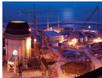
2.4.4.5-2. ábra: A Shin-Kori erőmű építési munkái
