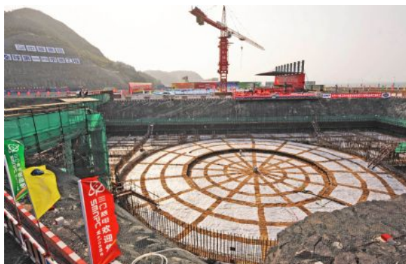
2.4.4.1-2. ábra: Haiyang 2. építése
